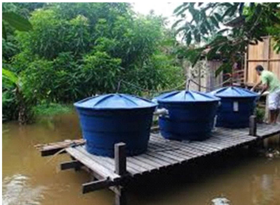
Figura 10. Foto de uma Fossa Séptica Biodigestora adaptada para regiões ribeirinhas (Oliveira et al., 2018).
